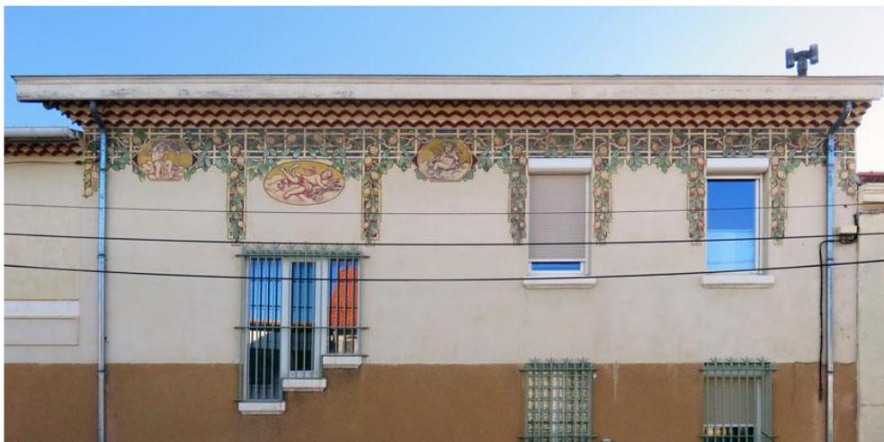
Les séries de tuiles incurvées sortant du mur et dont les interstices sont remplis de plâtre, soutenant l'avancée du toit, qui protège les murs de la pluie, se nomment « *génoise* ». On trouve 2 rangs sur les maisons modestes et 3 à 4 rangs sur les maisons riches.
